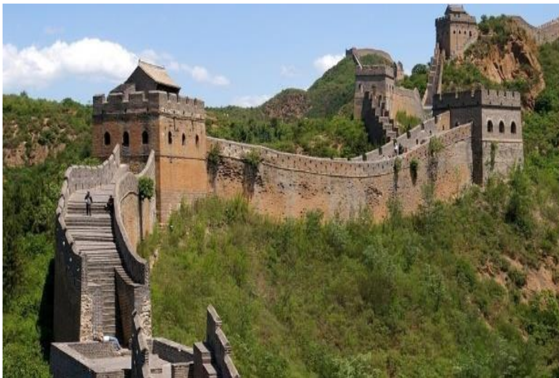
Figura 1. Grande Muralha da China
