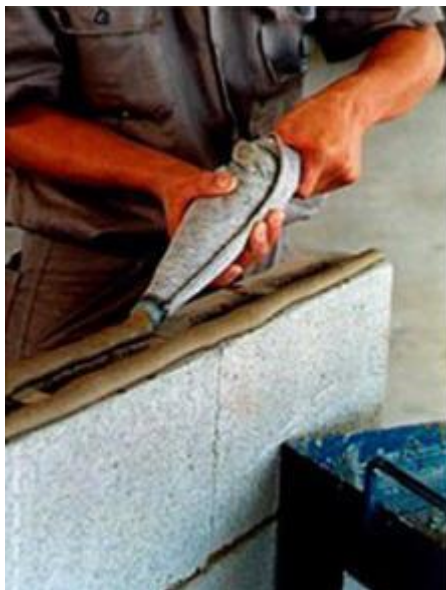
Figura 27 bisnaga para aplicação de argamassa de assentamento.
