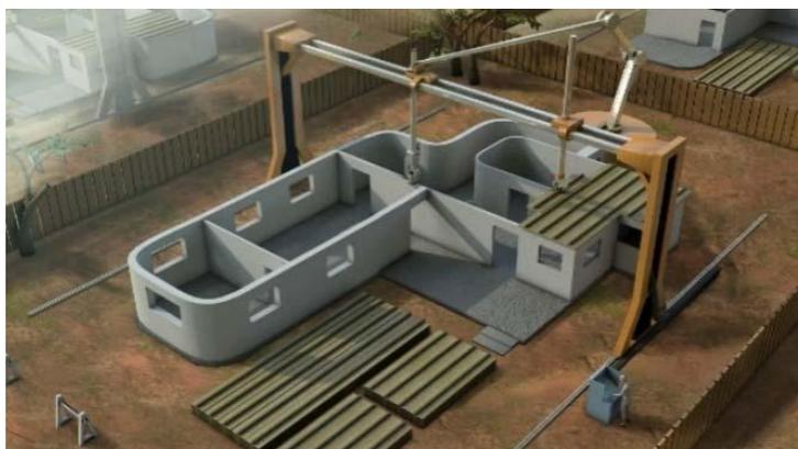
*Figura 3 - Esquema de construção com Contour Crafting. Fonte: CONTOUR CRAFTING (2016)*
