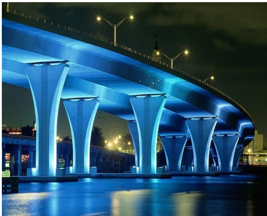
Figura 12- Construção de viadutos com aços microligados ao nióbio.
