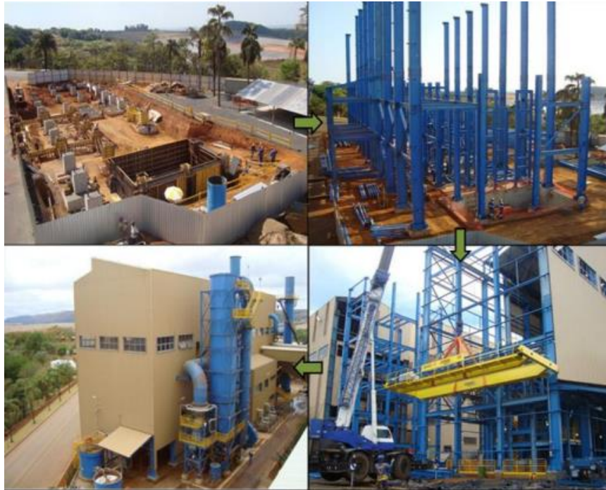
Figura 19- Construção da fábrica sinterização da CBMM em Araxá, Minas gerais Fonte: Pimenta e Silvestre (2011)
