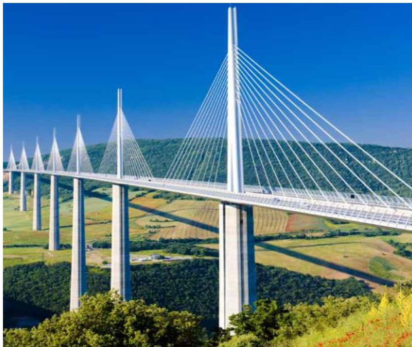
Figura 16-Nióbio aplicado em aços estruturais: Ponte do Vale do Millau na França Fonte: (CBMM, 2017)
