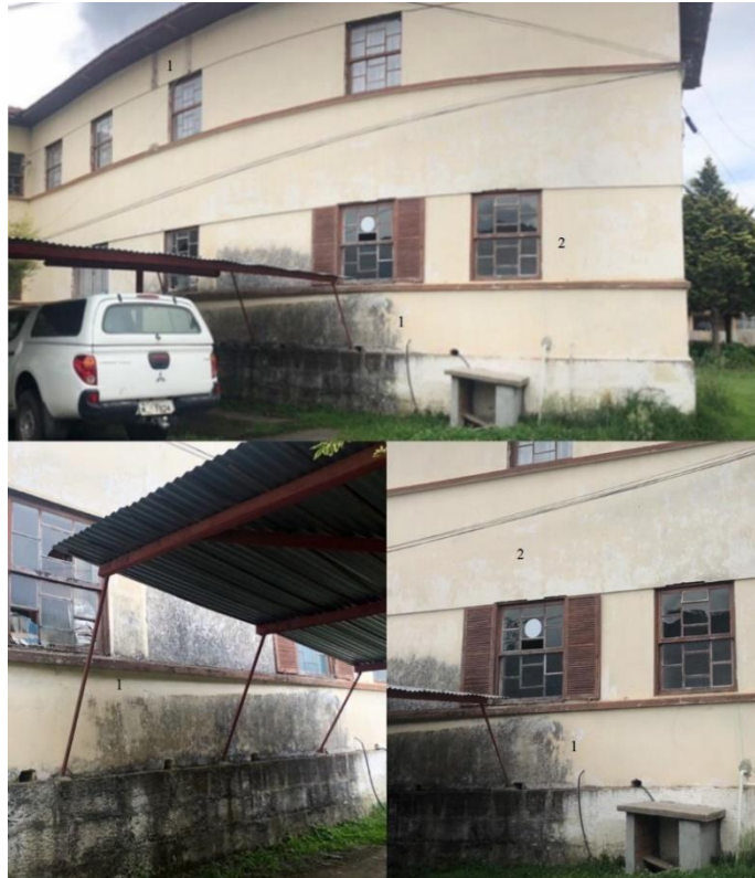
Figura 11: Situação atual - Fachada F
