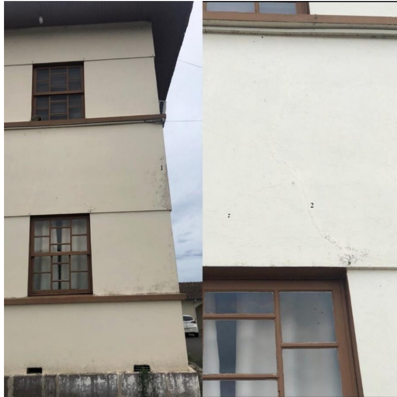
Figura 6: Situação atual - Fachada A
