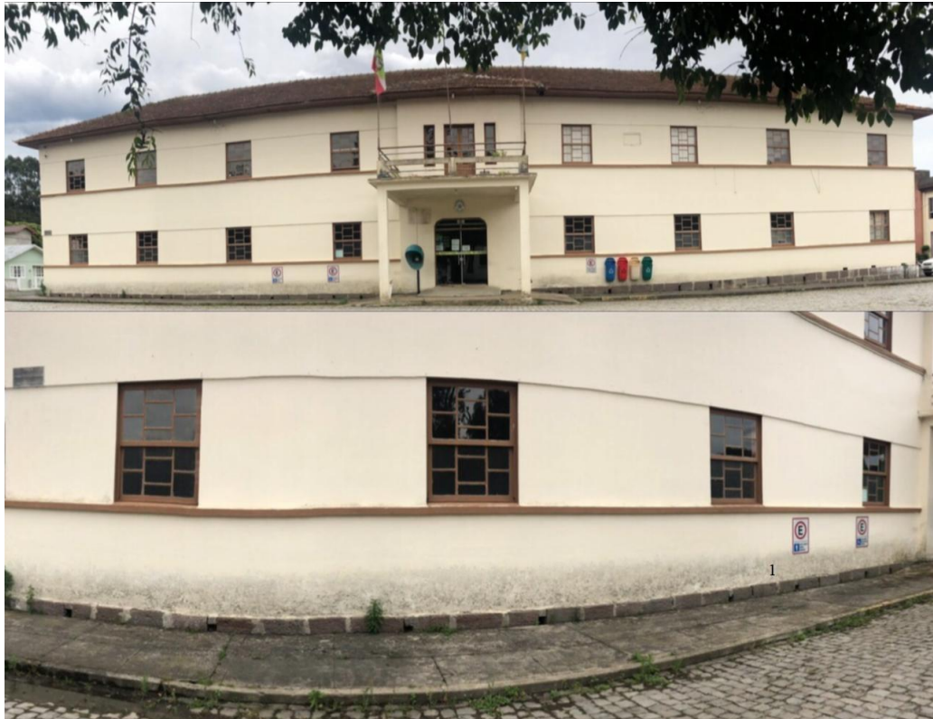
Figura 5: Situação atual - Fachada A
