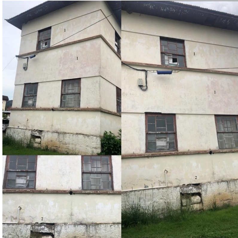
Figura 10: Situação atual - Fachada E
