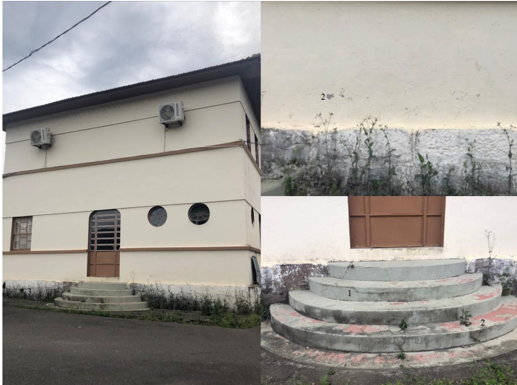
Figura 13: Situação atual - Fachada H
