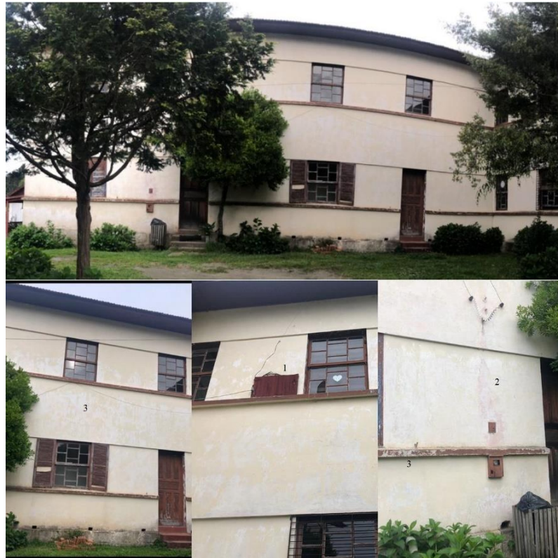
Figura 9: Situação atual - Fachada D
