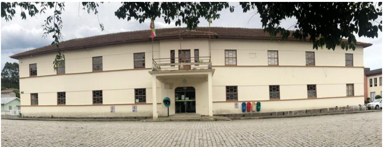
Figura 2: Fachada principal da Prefeitura Municipal de Urubici
