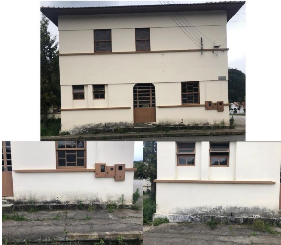
Figura 7: Situação atual - Fachada B
