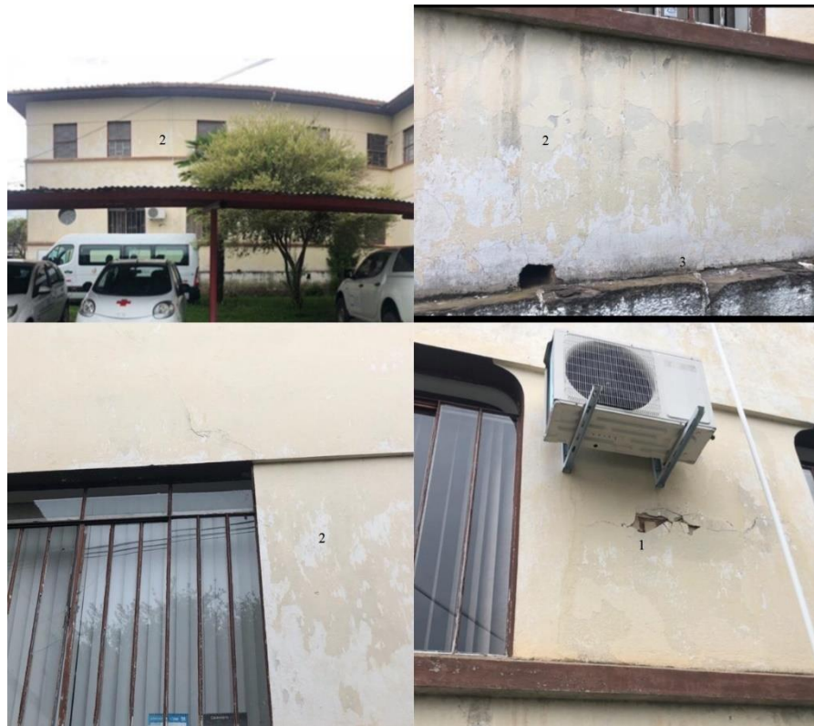
Figura 12: Situação atual - Fachada G
