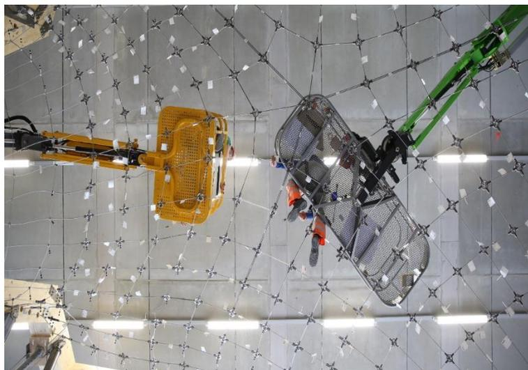
Figura 10 – Protótipo Nest Hilo – montagem da rede de cabos.
