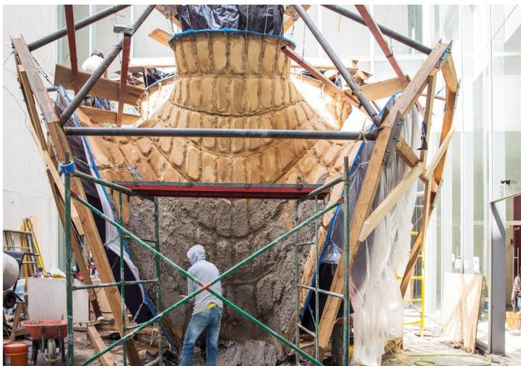
Figura 13 – Projeto KnitCandela – processo de construção.
