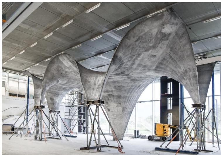
Figura 8 – Protótipo Nest Hilo – estrutura concretada.
