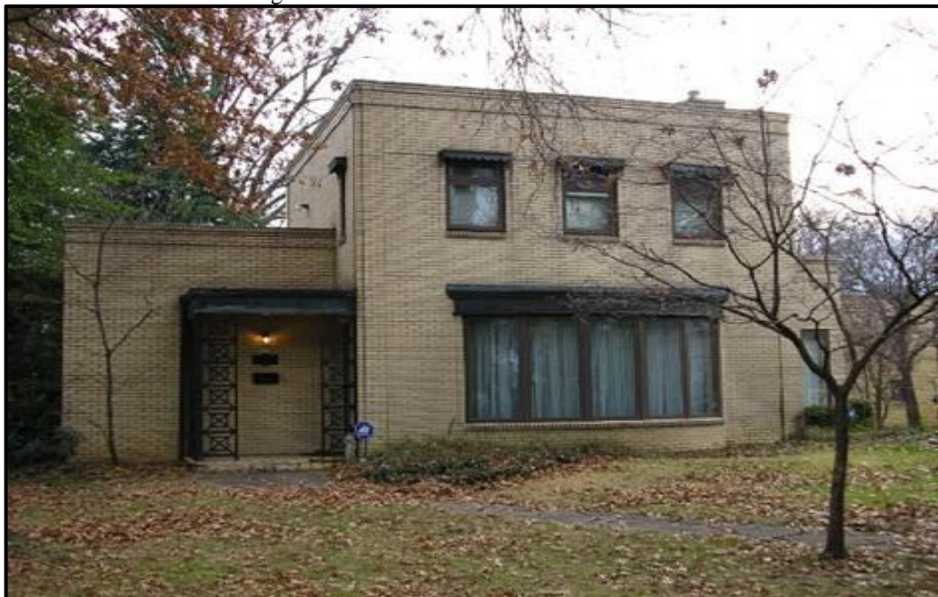
Figura 6: Primeira residência em Steel-Frame.
