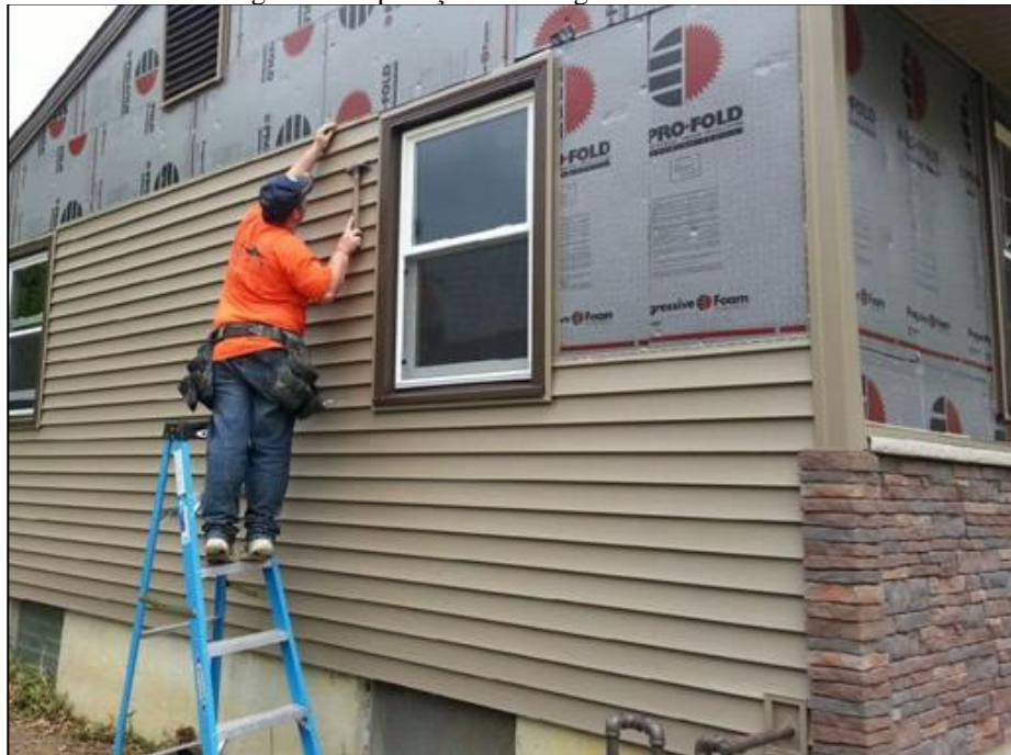
Figura 24: Aplicação de siding vinílico.
