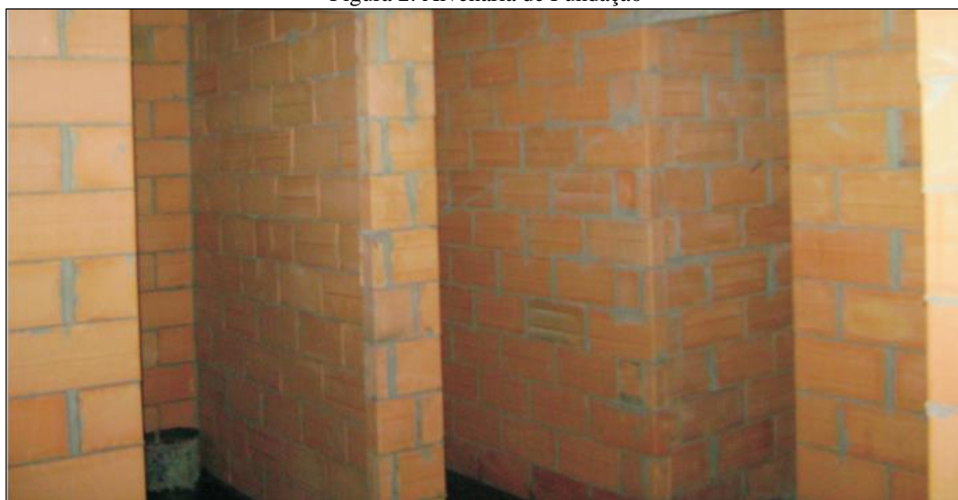
Figura 2: Alvenaria de Fundação
