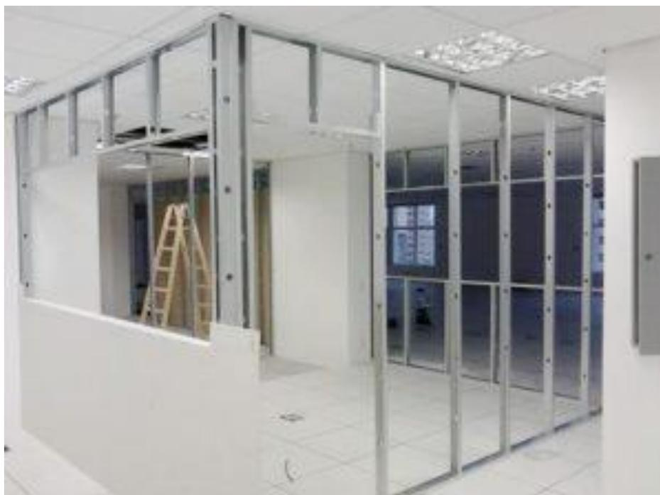
**Figura 1** – Esquema de execução dos guias e montantes
