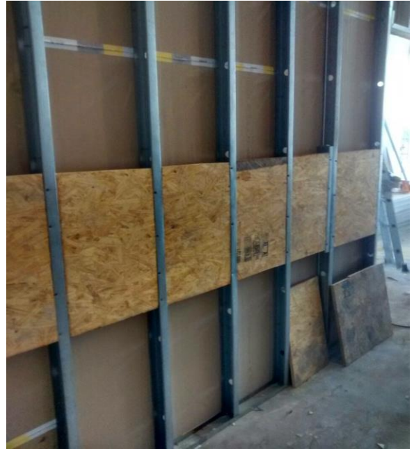
Figura 6: Colocação dos reforços de madeira.
