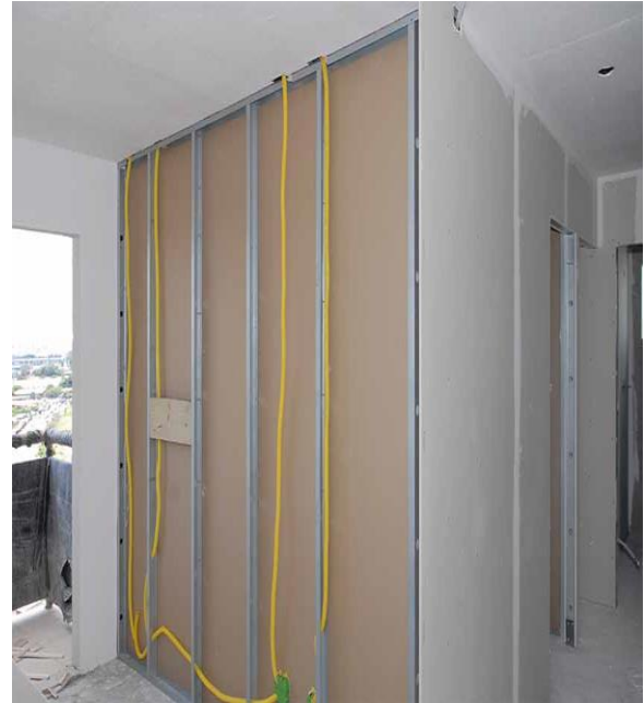
Figura 4: Fixação das placas.
