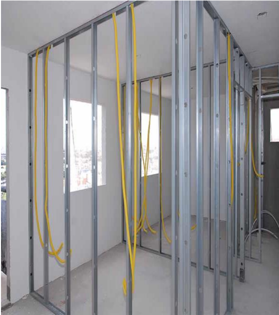
Figura 3: Fixação das guias.
