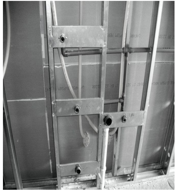
Figura 8: Instalações hidráulicas, gás.
