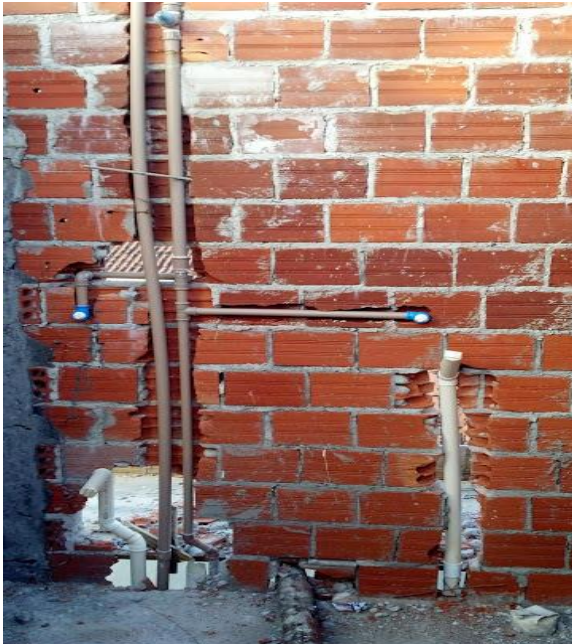
Figura 1: Rasgos feitos para passar rede hidráulica.
