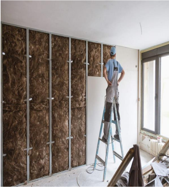
Figura 5: Colocação da lã de vidro.
