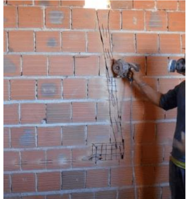
Figura 2: Rasgos feitos para passar rede elétrica.
