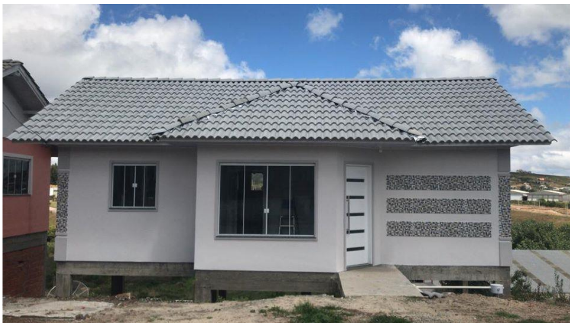
Figura 17 – fachada existente (fonte: a autora)
