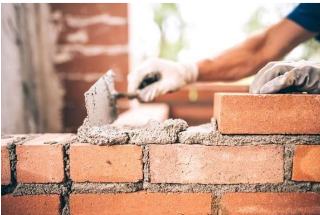
Figura 13: Execução de alvenaria convencional. Fonte: BARTUCCI, 2020.
