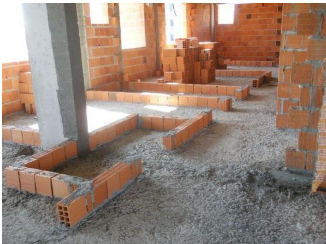
Figura 14: Primeira fiada de blocos cerâmicos. Fonte: UFRGS, 2011.
