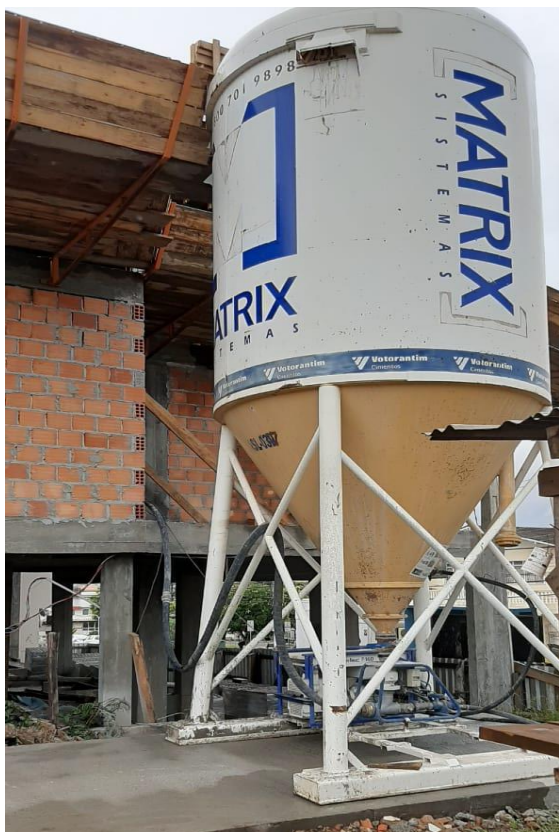
Figura 8 – Silo de argamassa
