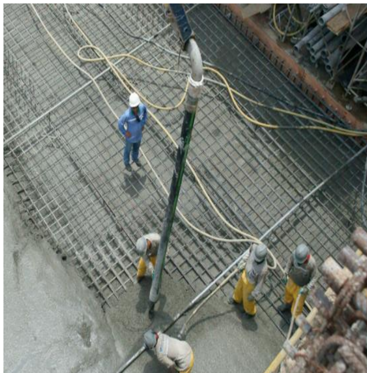
Foto: 04, Concreto Bombeável
