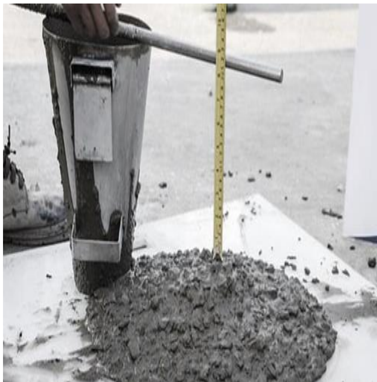
Foto:03 , Execução Do SLUMP TEST
