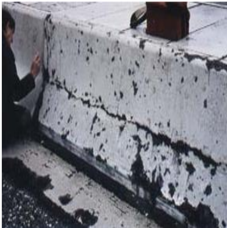
Foto:16, Concreto Impregnado Por Polímeros
