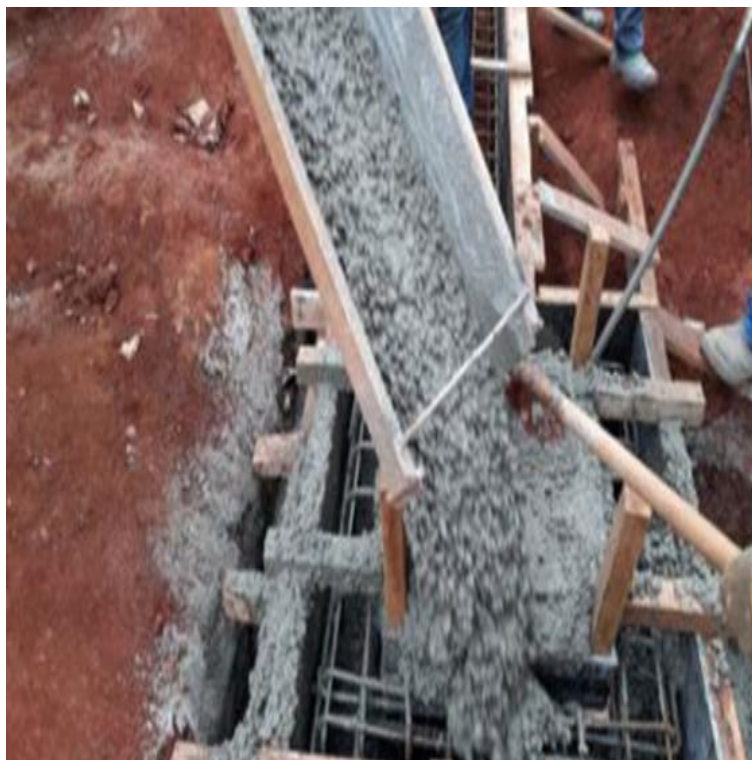
Foto:02 , Concreto Convencional
