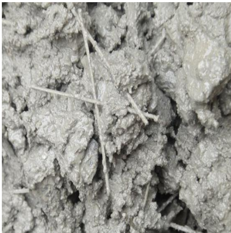
Foto:15 , Concreto Impregnado Por Polímeros
