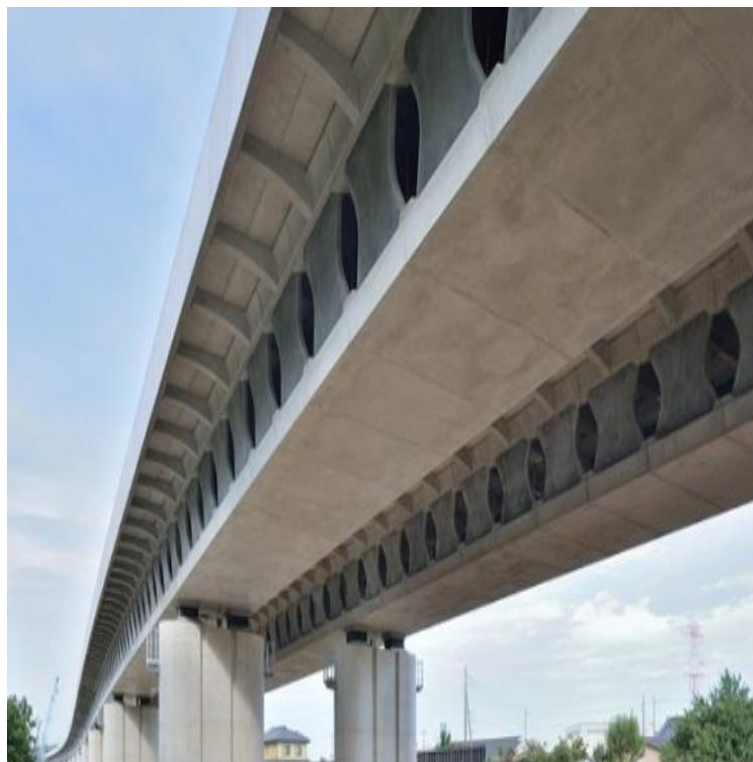
Foto:08 , Concreto de Alta Resistência
