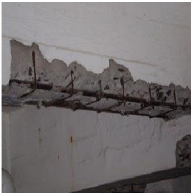
Foto: 11 , Segregação da camada protetora
