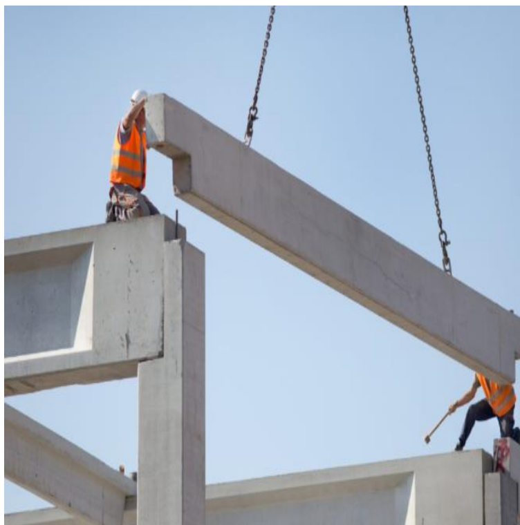
Foto: 05 , Concreto Armado
