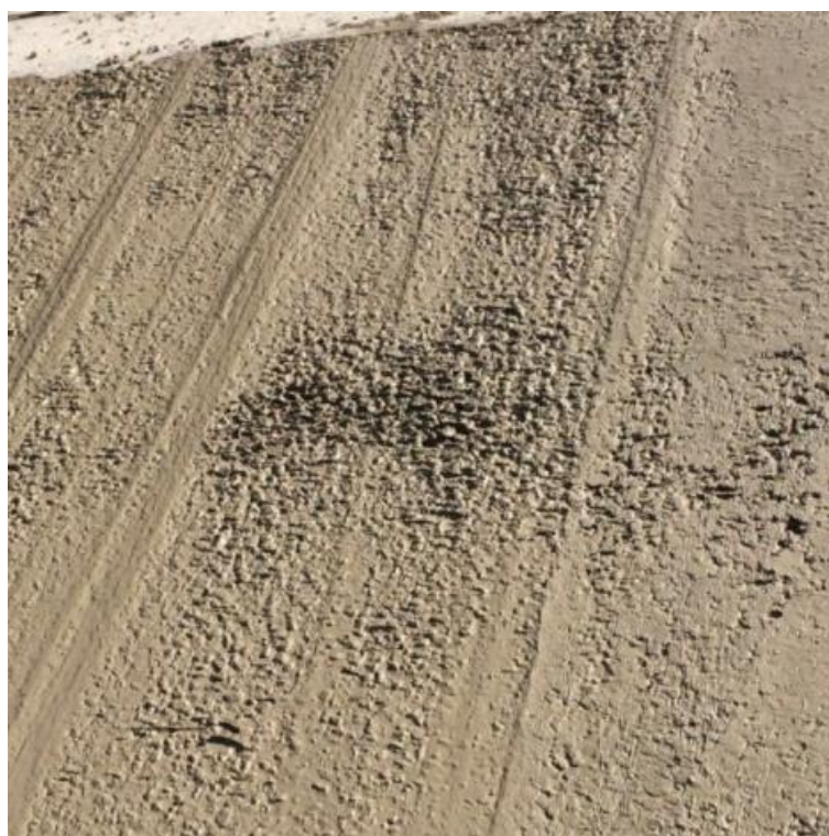
Foto:22 , -Concreto Polimérico
