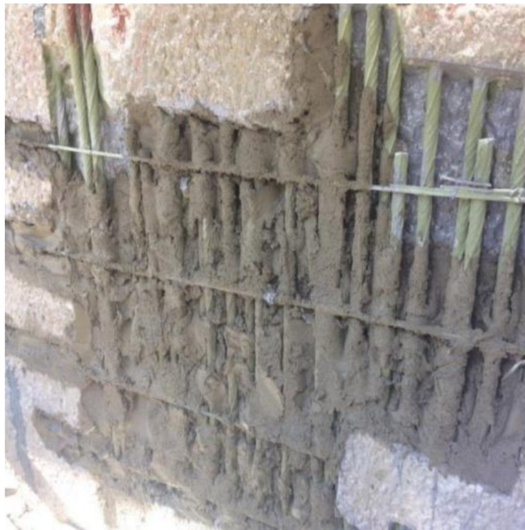
Foto:18 , Argamassa Polimérica Com Inibidor De Corrosão
