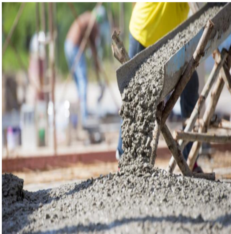
Foto: 01, Concreto Sendo Lançado
