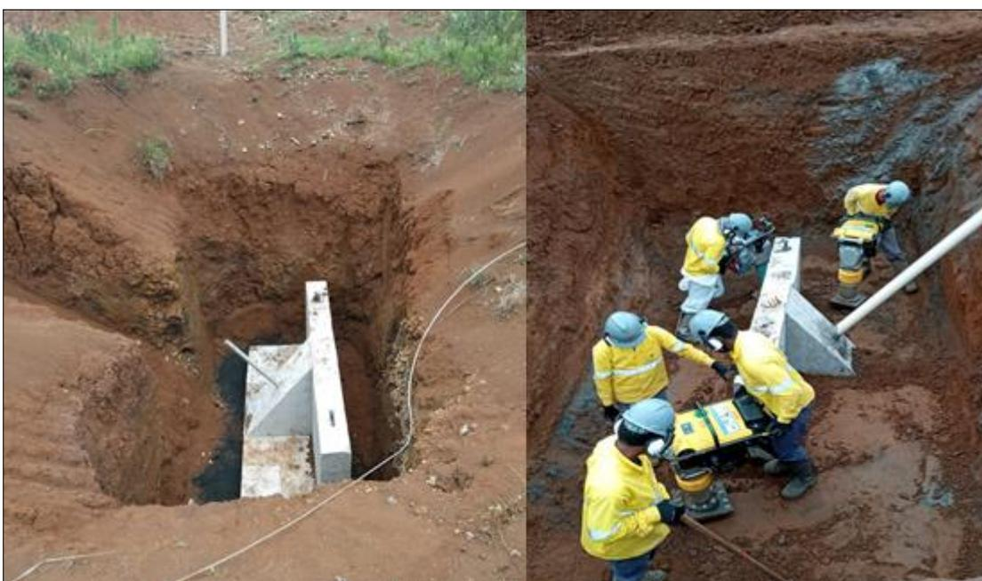
FIGURA 10 – Fundação tipo viga L em LT
