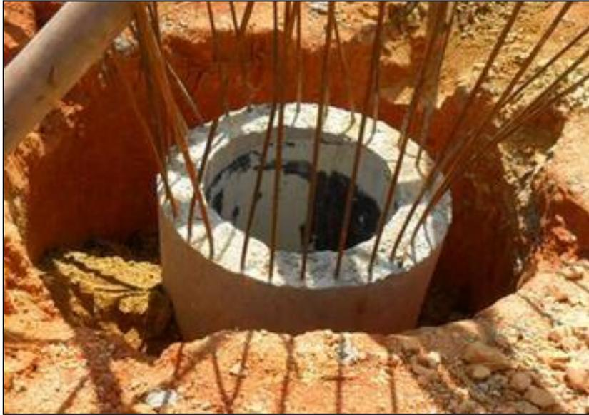
FIGURA 6 – Fundação Tipo Tubulão
