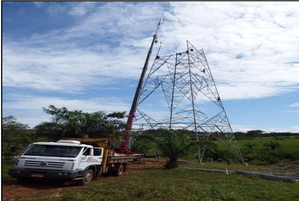
FIGURA 4 – Processo de Montagem Mistas das Torres
