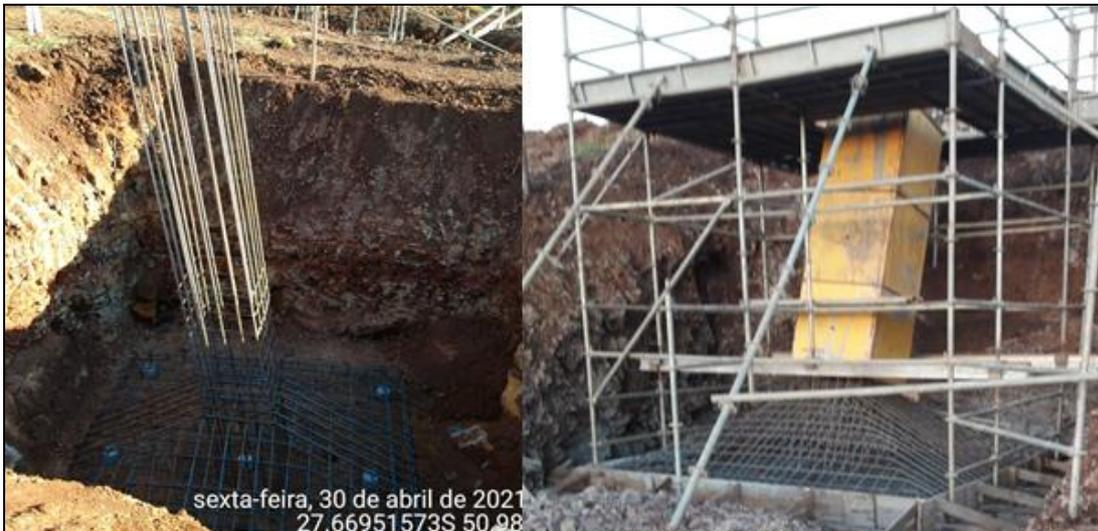
FIGURA 8 – Fundação tipo sapatas em LT
