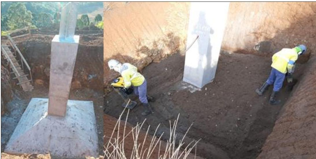
FIGURA 9 – Fundação tipo sapatas em LT
