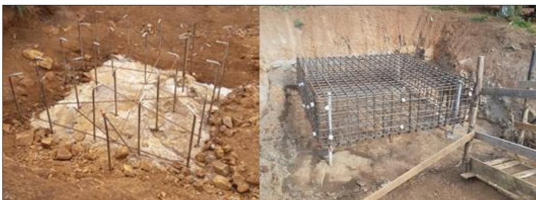
FIGURA 12 – Fundação tipo haste ancorada em rocha
