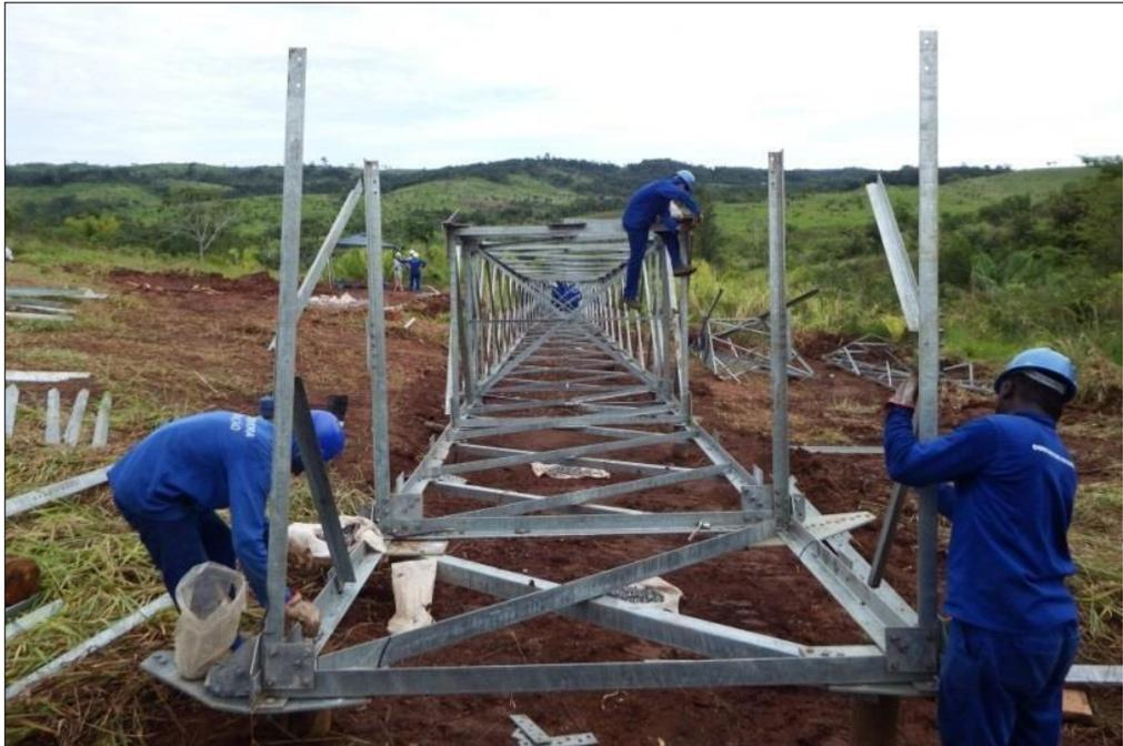
FIGURA 3 – Processo de Montagem das Torres
