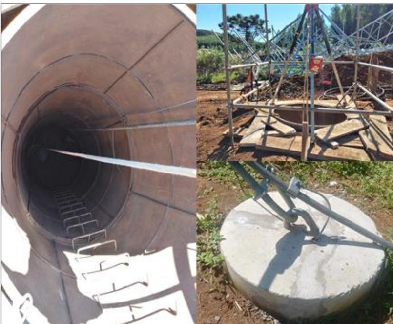
FIGURA 11 – Fundação tipo tubulão
