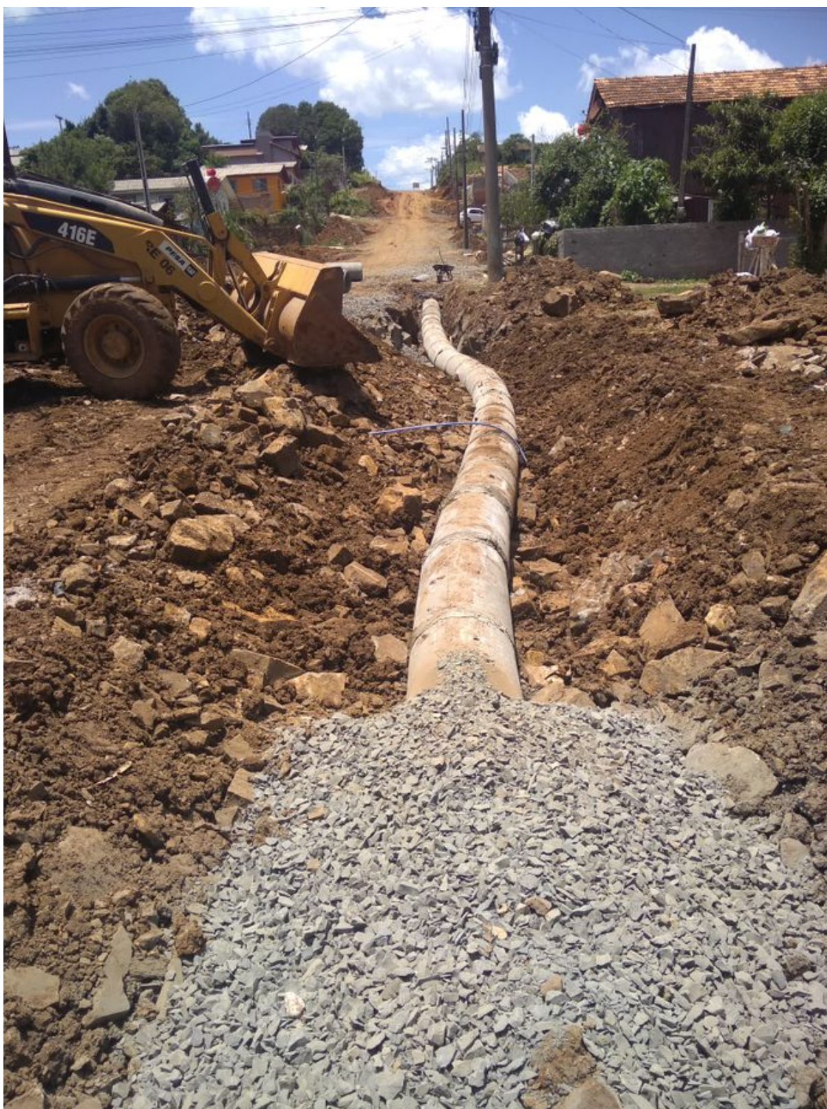
Imagem 5 - Parte da Drenagem realizada pela Prefeitura Municipal
