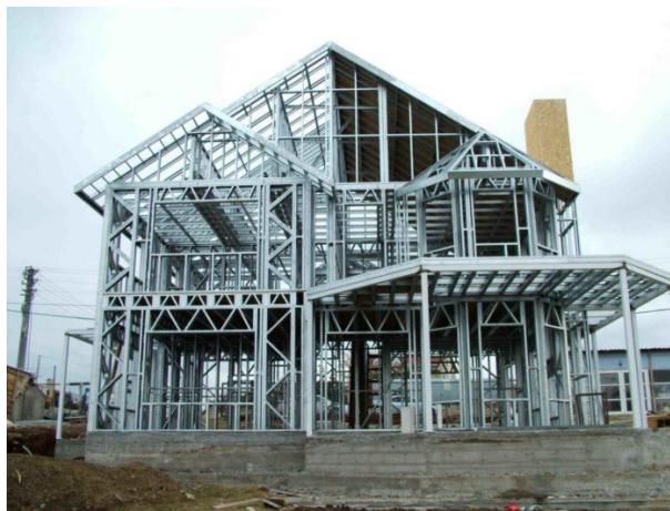
Figura 1 – Estrutura em aço galvanizado
