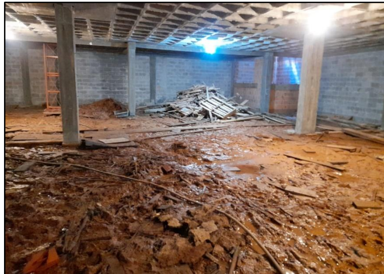
Figura 21: Pavimento subsolo antes da limpeza
