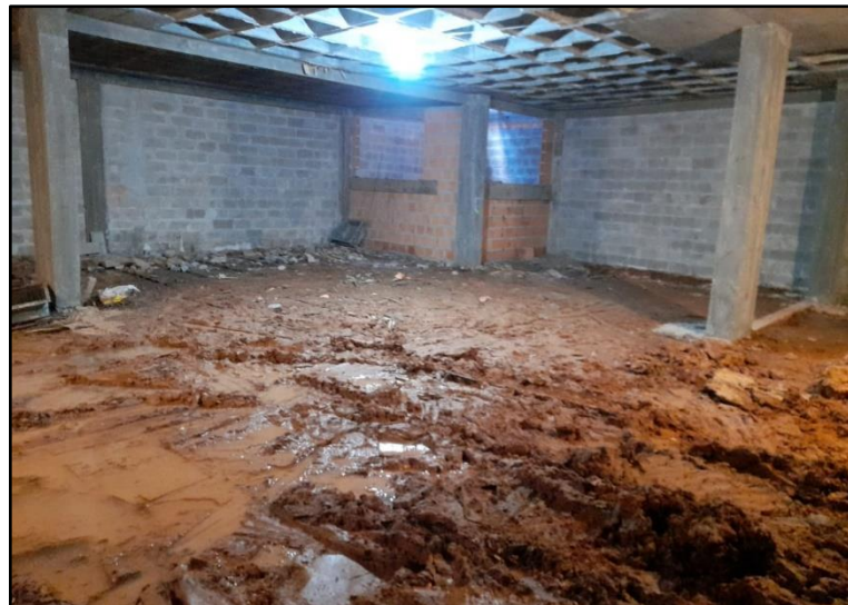
Figura 22: Pavimento subsolo após a limpeza
