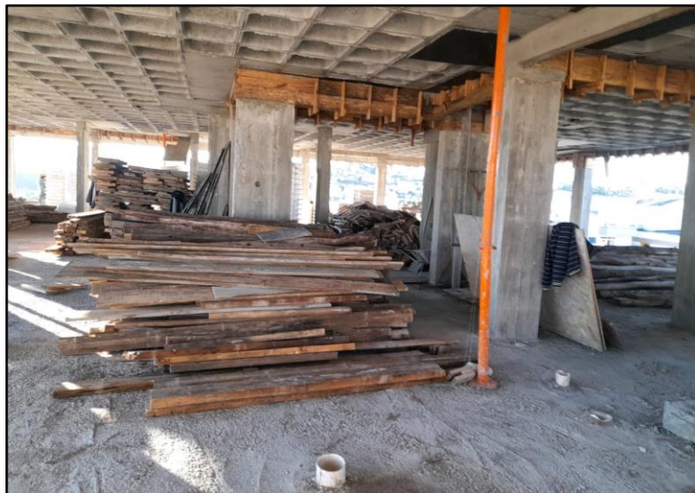
Figura 26: Laje durante o processo de organização e limpeza
