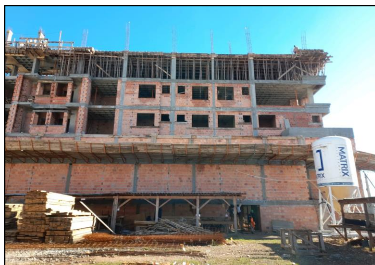
Figura 10: Vista lateral do edifício em construção
