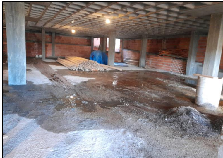
Figura 28: Laje do térreo após limpeza
