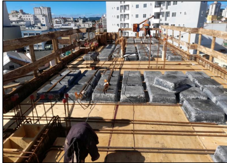
Figura 33: Laje após aplicação das proteções
