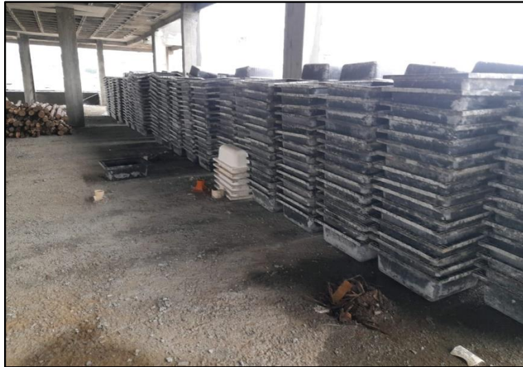
Figura 25: Empilhamento de cubetas para organização da laje
