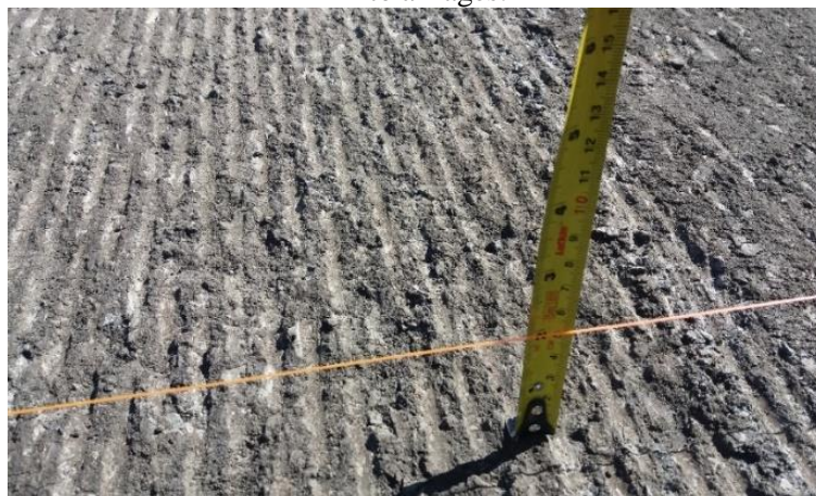
Figura 16 – Exemplo de fresado a fim de recompor a capa asfáltica de 5 cm no trecho entre Correia Pinto a Lages.
