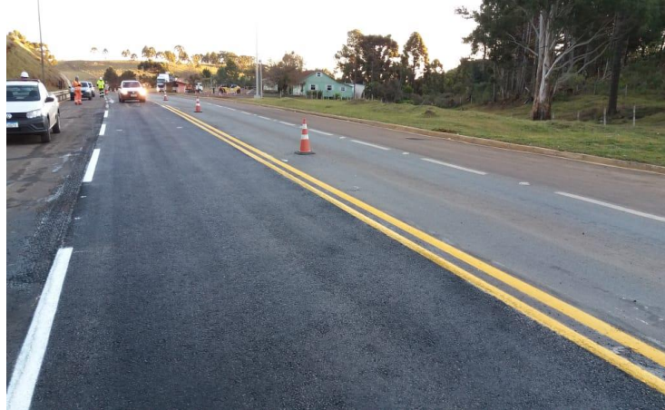
Figura 15 – Trecho da BR – 116 com correção na deformação plástica.
