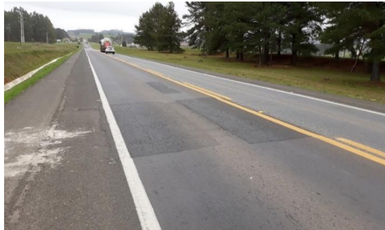
Figura 14 – Exemplo de Remendo feito na BR – 116.
