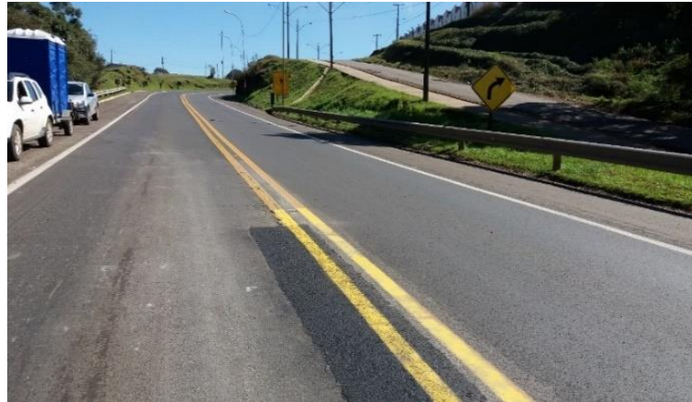
Figura 13 – Remendo feito para correção de panela no trecho entre Correia Pinto a Lages.
