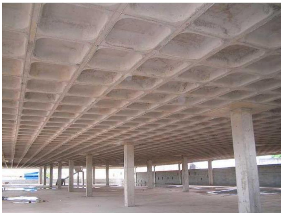
Figura 3 - Laje nervurada com nervuras aparentes
