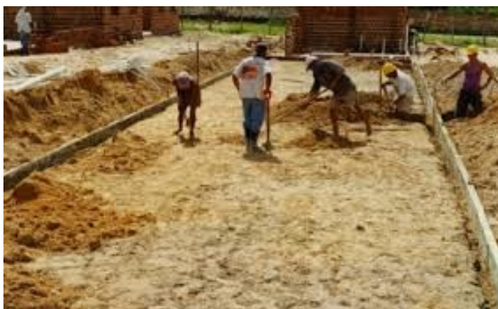
Figura 6 – Preparo do terreno
