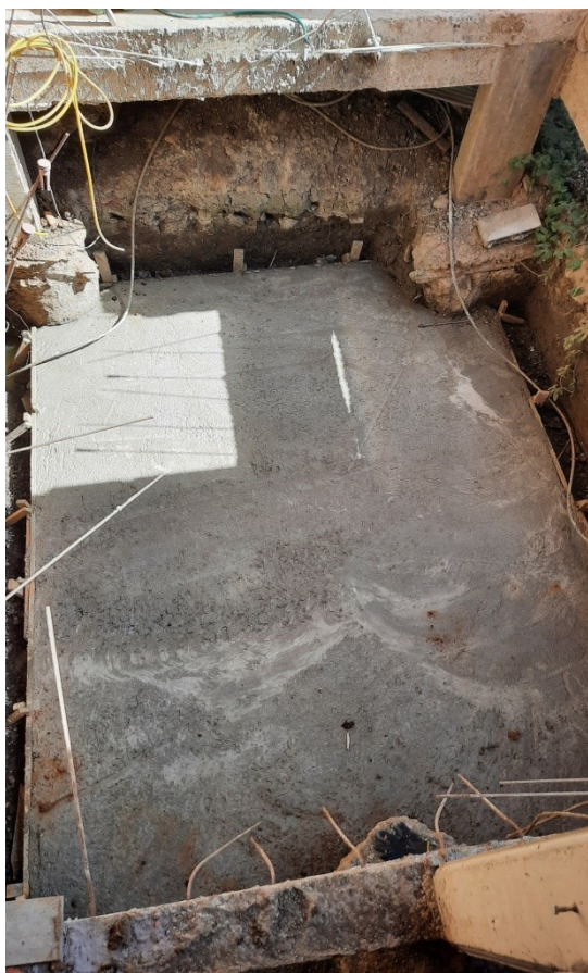
Figura 18 – Radier totalmente executado
