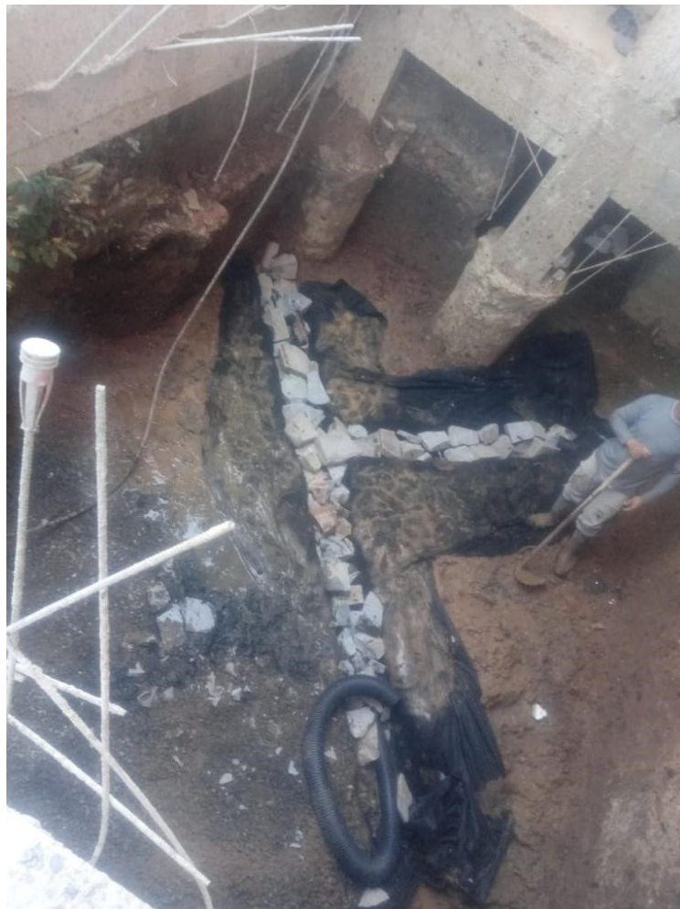
Figura 11 – Adequação do dreno
