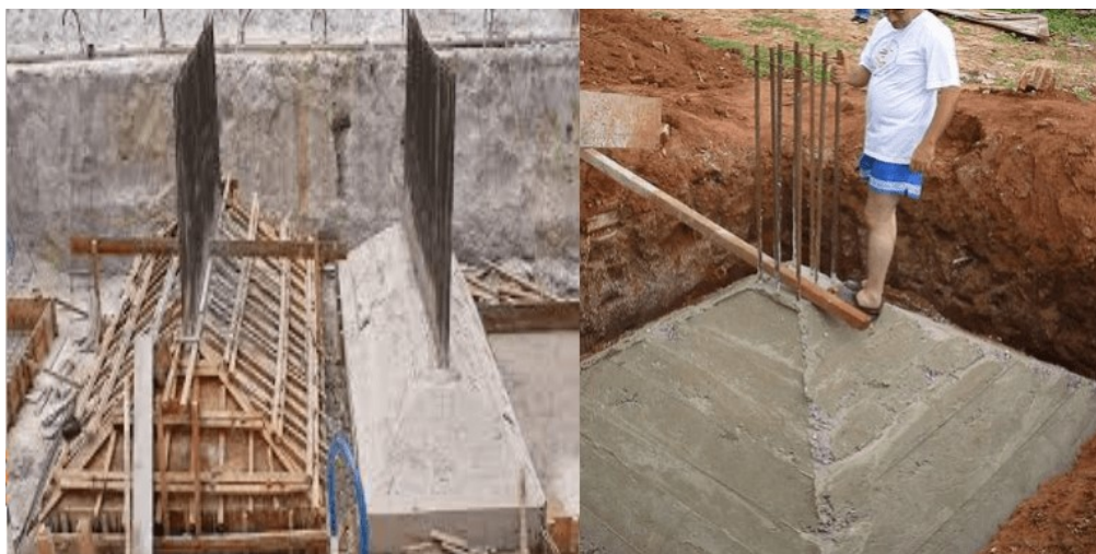
Figura 1 – Sapata isolada
