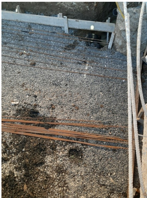
Figura 14 – Posicionamento das ferragens
