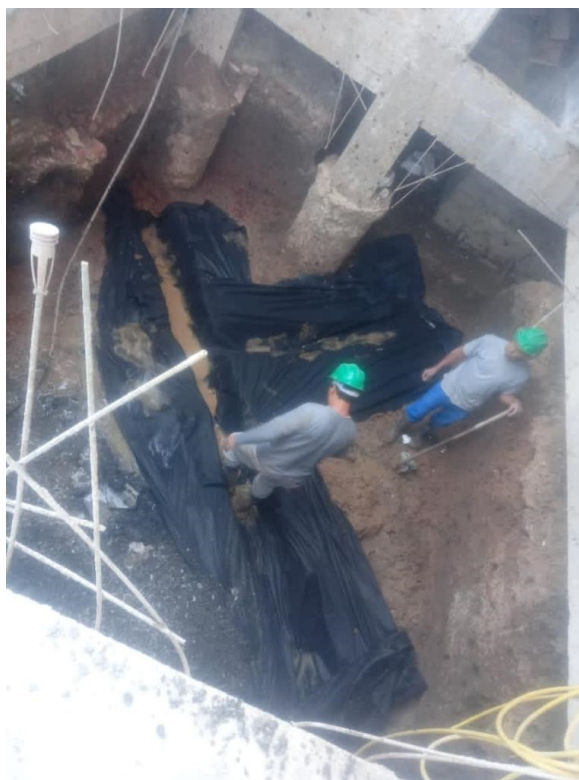
Figura 10 - Escavação da superfície e execução do dreno
