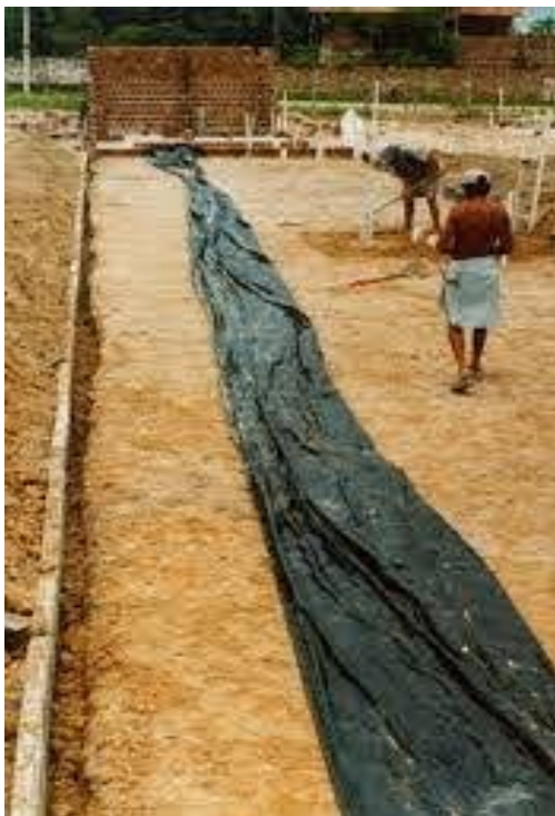
Figura 7 - Engrossamento das bordas com filme plástico para isolamento
