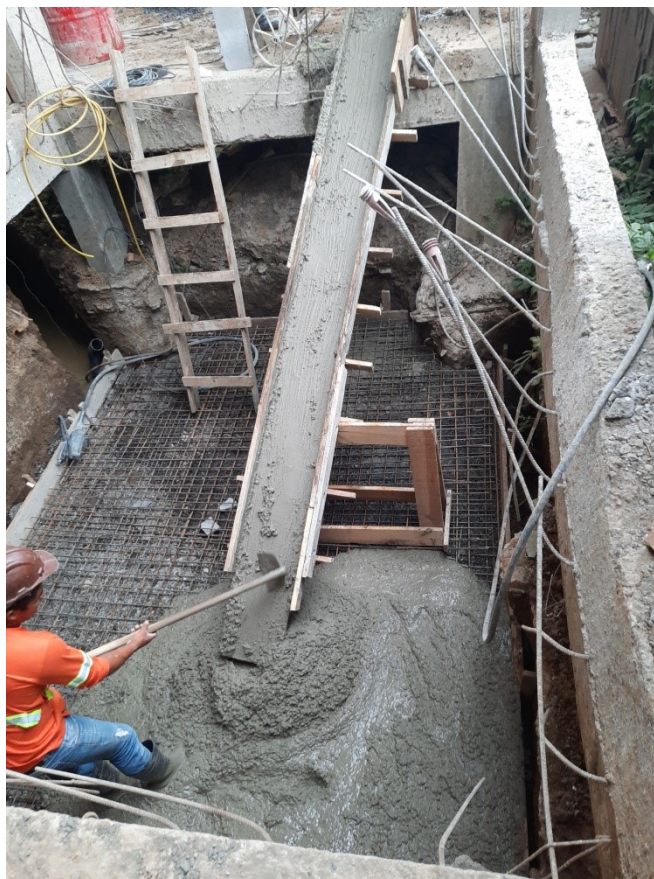
Figura 17 – Execução da concretagem
