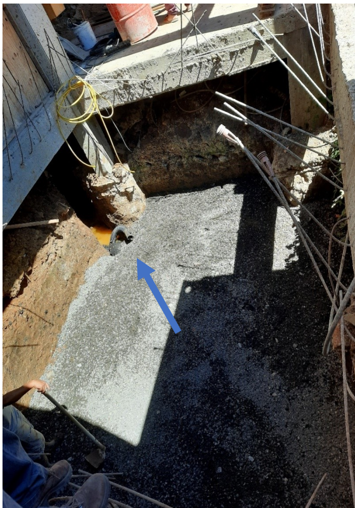
Figura 12 – Posição do dreno e lastro de brita
