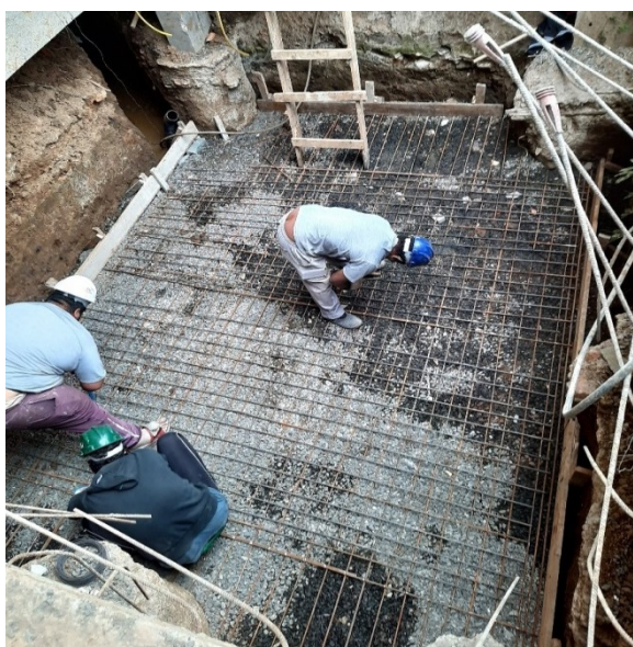
Figura 16 – Amarração da armadura
