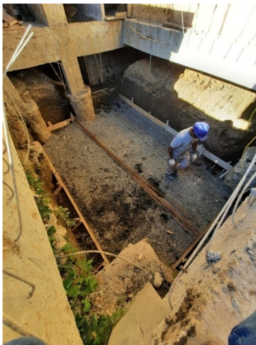
Figura 15 – Posicionamento das armaduras
