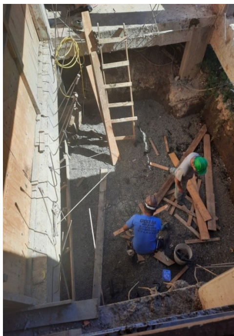
Figura 13 - Planejamento e verificação das madeiras para fechamento lateral
