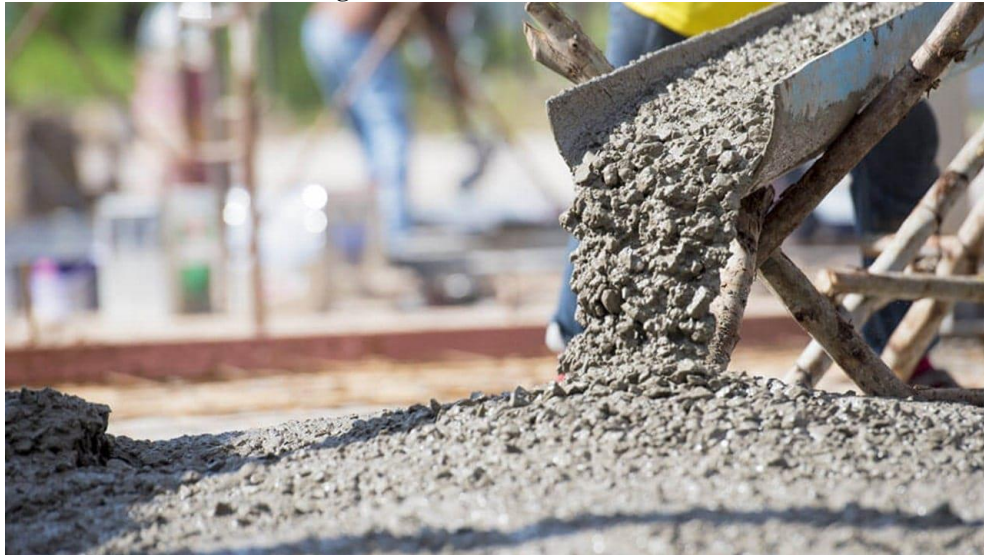
Figura 15: Concreto sendo locado
