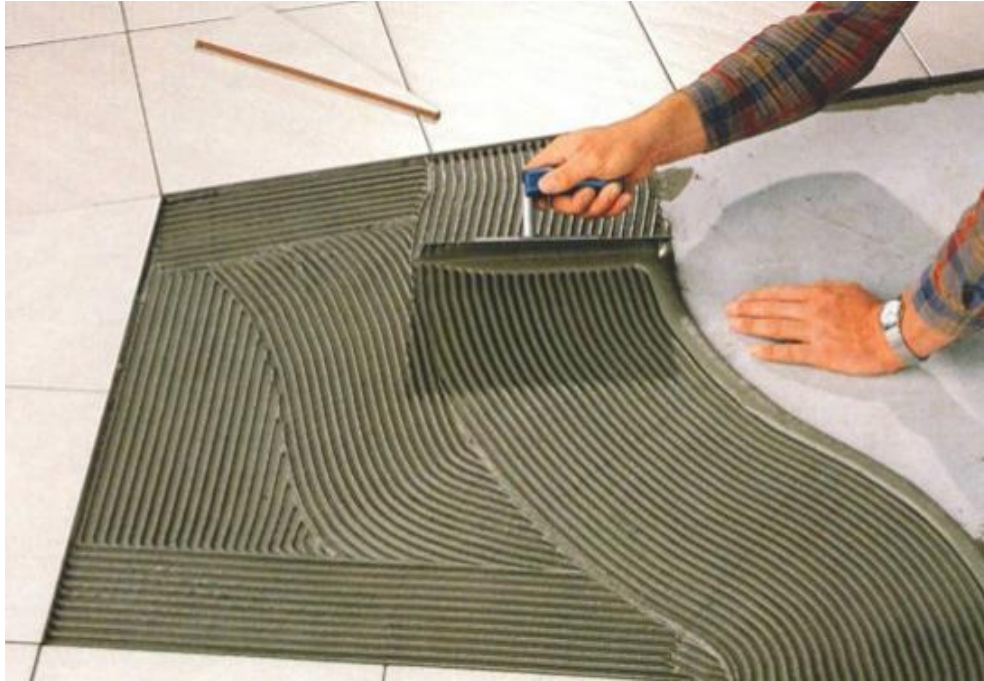
Figura 4: Aplicação de argamassa
