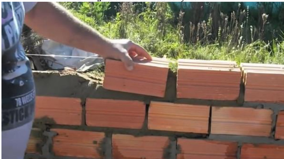
Figura 6: Assentamento de tijolos
