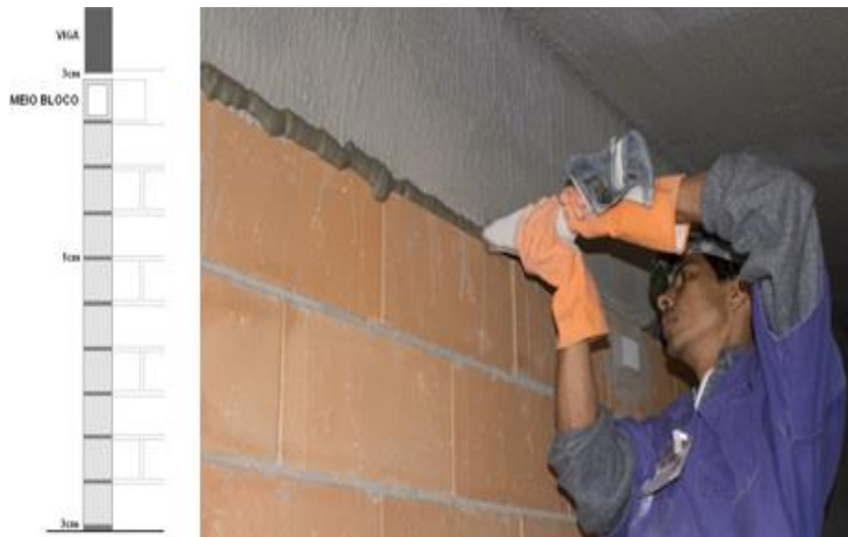
Figura 10: Encunhamento com argamassa
