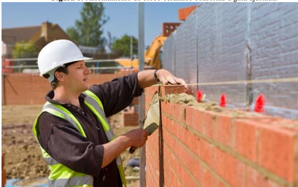
Figura 8: Assentamento de bloco cerâmico conforme a guia ajustada.
