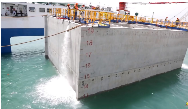
Figura 7: Caixaão fechado sendo transportado até o local da fundação.
