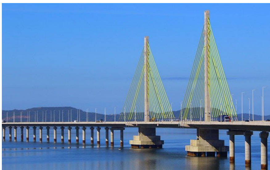
Figura 15: Ponte de Laguna/SC.
