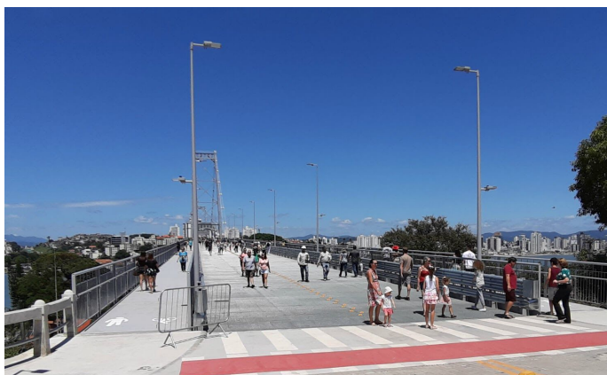
Figura 20: Ponte Hercílio Luz após reforma.
