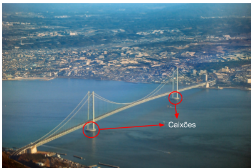
Figura 14: Caixões da ponte Akashi-Kaikyo.
