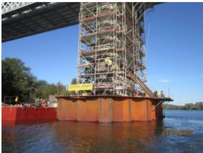
Figura 10: Ensecadeira instalada para execução de reparos em fundação.
