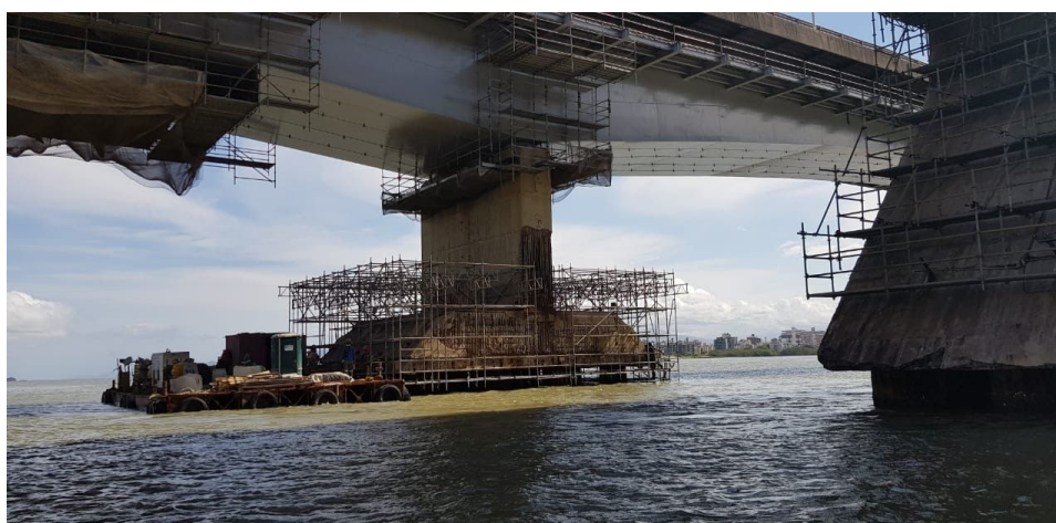
Figura 16: Obras no sistema estrutural das pontes Pedro Ivo e Colombo Salles.
