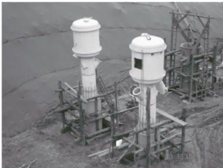
Figura 6: Tubulão a ar comprimido.
