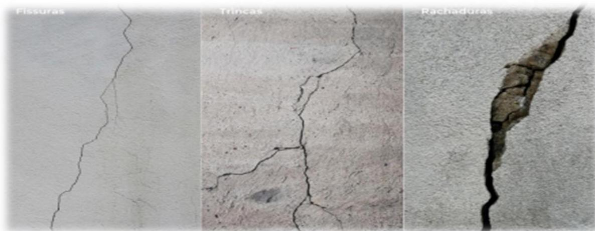
Figura 03 – Fissuras, trincas e rachaduras.
