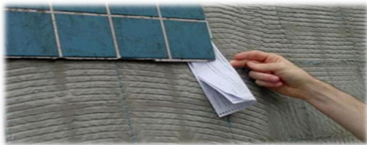
Figura 06 – Descolamento de revestimento cerâmico
