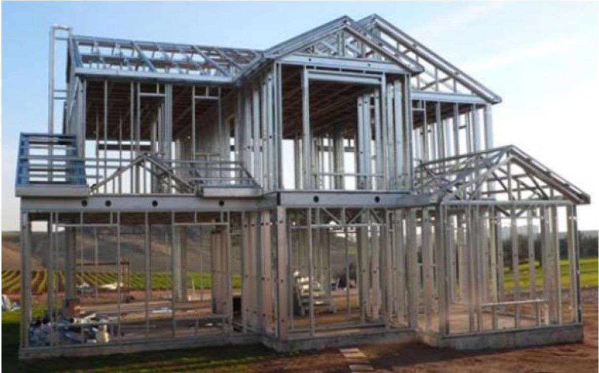
Figura 3 - Construções em Steel Frame
