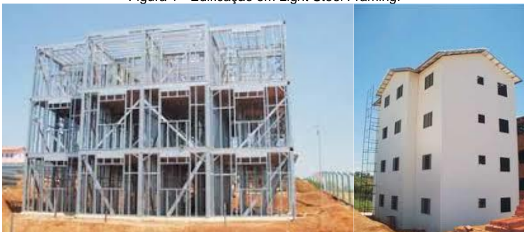
Figura 1 - Edificação em Light Steel Framing.
