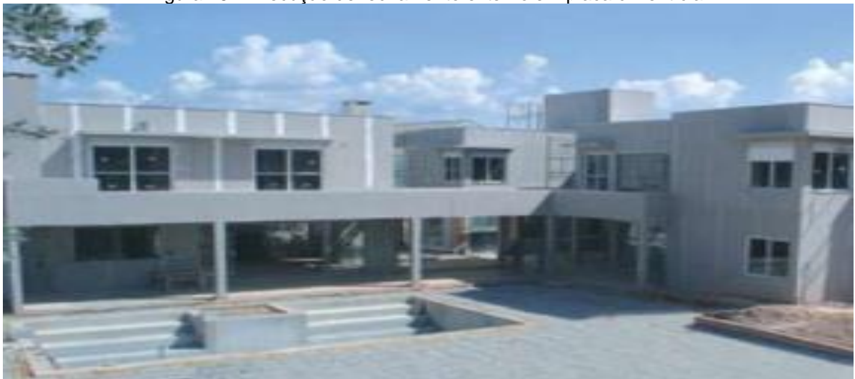
Figura 16 - Execução de fechamento externo em placa cimentícia.
