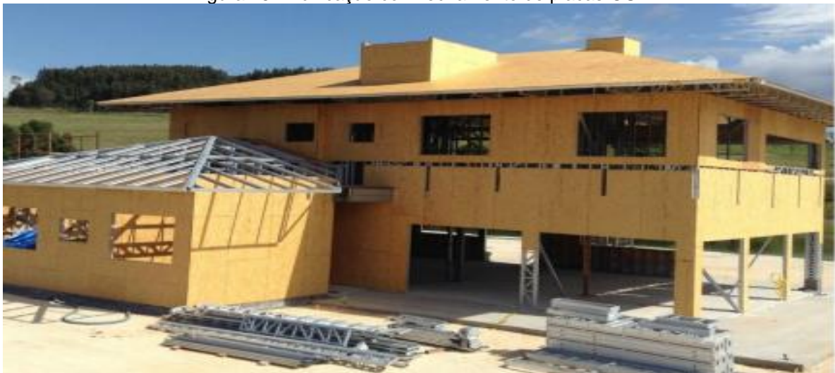
Figura 15 - Edificação com fechamento de placas OSB.
