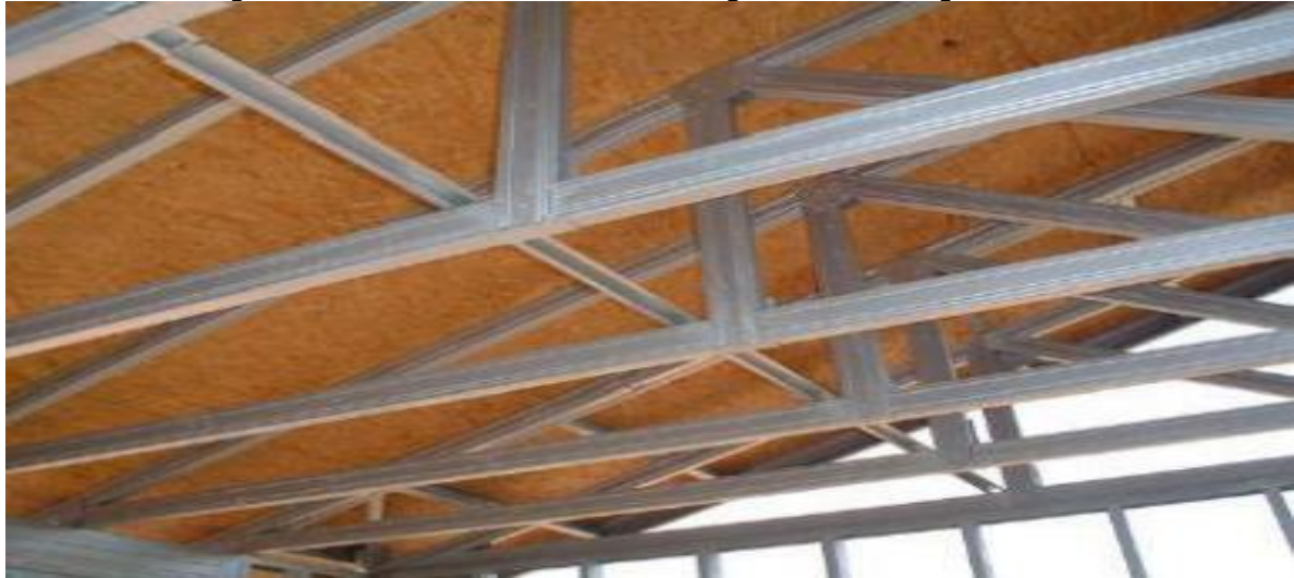
Figura 19 - Tesouras de cobertura em Light Steel Framing com OSB.
