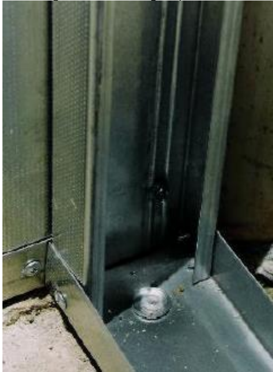
Figura 12 - Ancoragem provisória.
