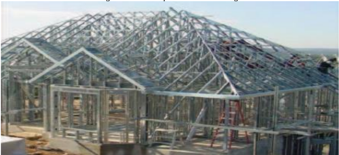
Figura 2 - Construção em Steel Framing.
